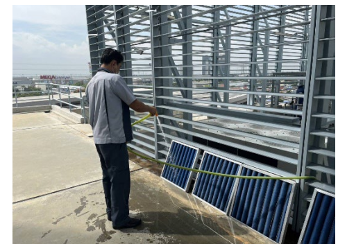
ภาพที่ 2.1-49 การทำความสะอาดแผ่นกรองอากาศ
